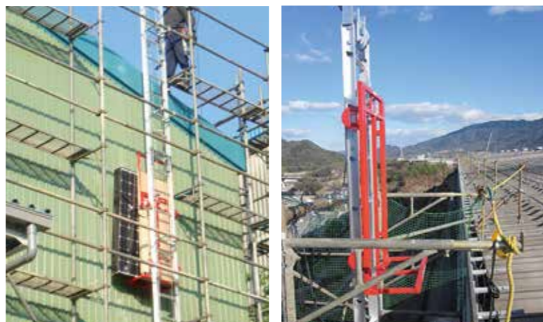
足場の内側に設置し、屋根上まで荷揚げ可能。ウインチ操作は屋根上でも可能
