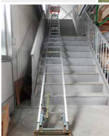
【階段設置】階段の角度に合わせて中間曲りレール を1ヶ所に入れて設置した仕様
