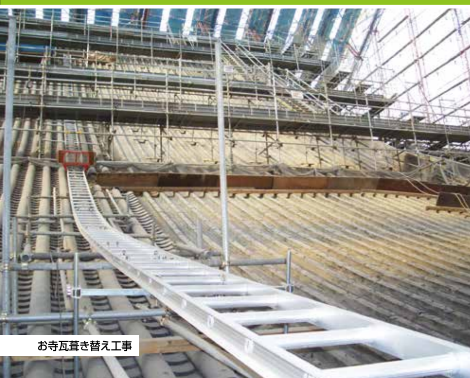
階段設置工事
