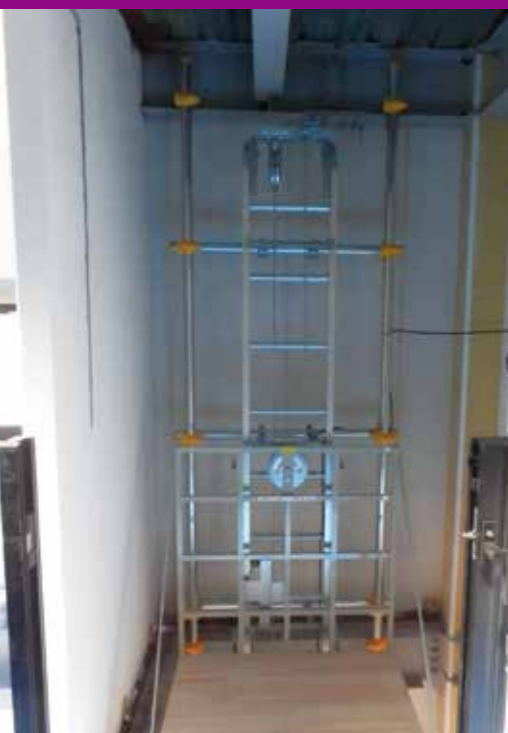
【垂直設置】鉄骨造の建物の梁部分に固定クラ ンプで単管パイプを設置し、レールの固定を簡 易的にできる仕様
